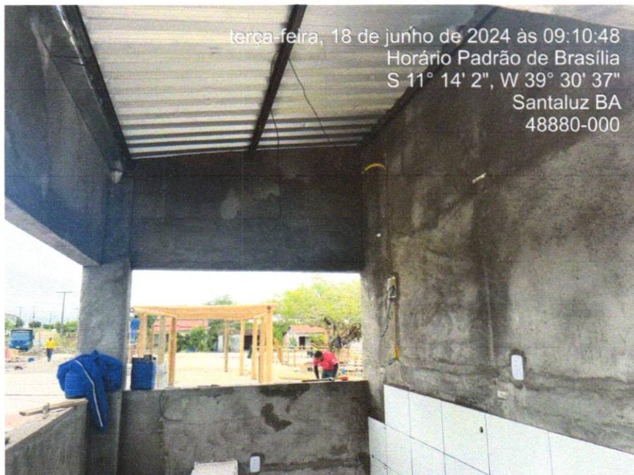
Foto 14 - Estrutura Metálica p/ Cobertura c/Vigas-Treliça Pratt UDC75 e terças em UDC 127, 2 águas, sem lanternin, vãos 6,0 a 10,0m, pintado 1 d oxido ferro + 2 d esmalte epóxi branco, exceto forn. Telhas - Executada
