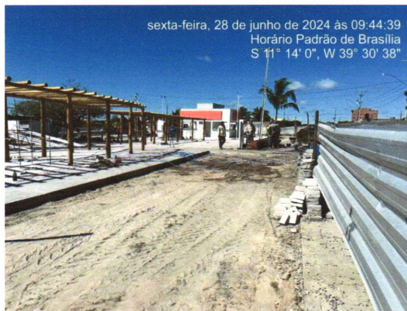
Foto 02 - REGULARIZAÇÃO E COMPACTAÇÃO DE SUBLEITO DE SOLO PREDOMINANTEMENTE ARENOSO. AF_11/2019
