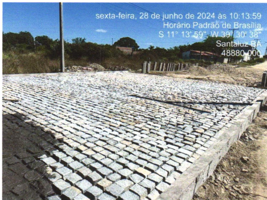
Foto 32 – PAVIMENTAÇÃO EM PARALELEPIPEDO
