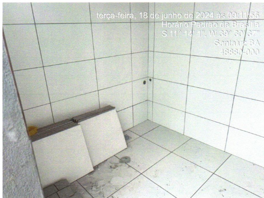
Foto 04 - REVESTIMENTO CERÂMICO PARA PISO COM PLACAS TIPO ESMALTADA EXTRA DE DIMENSÕES 35X35 CM APLICADA EM AMBIENTES DE ÁREA ENTRE 5 M2 E 10 M2. AF_06/2014
