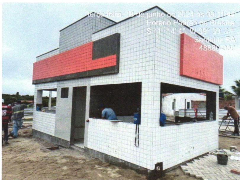
Foto 34 – REVESTIMENTO CERÂMICO PARA PAREDES EXTERNAS EM PASTILHAS DE PORCELANA 5 X 5 CM (PLACAS DE 30 X 30 CM), ALINHADAS A PRUMO, APLICADO EM SUPERFÍCIES EXTERNAS DA SACADA. AF_06/2014
