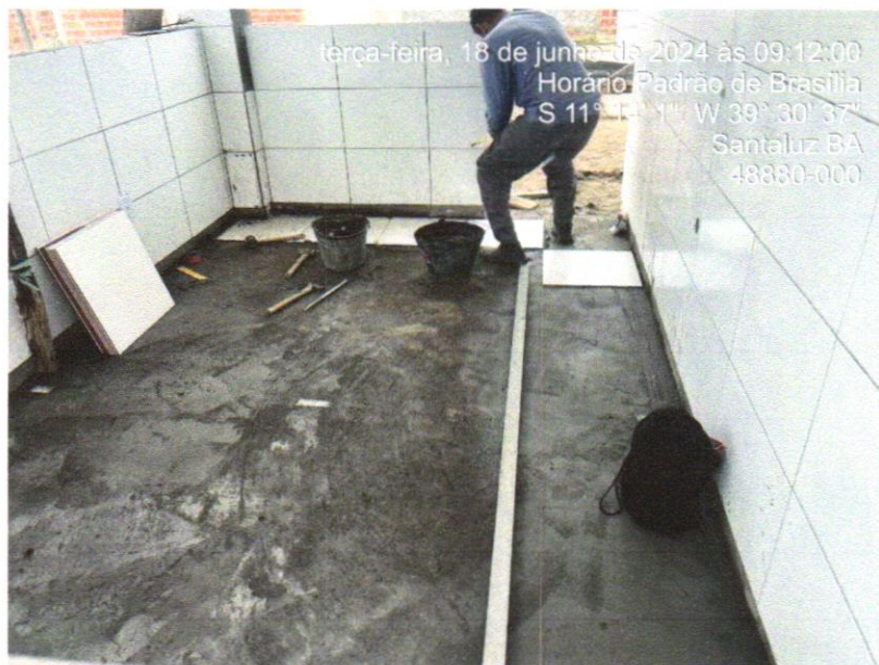
Foto 04 - REVESTIMENTO CERÂMICO PARA PISO COM PLACAS TIPO ESMALTADA EXTRA DE DIMENSÕES 35X35 CM APLICADA EM AMBIENTES DE ÁREA ENTRE 5 M2 E 10 M2. AF_06/2014
