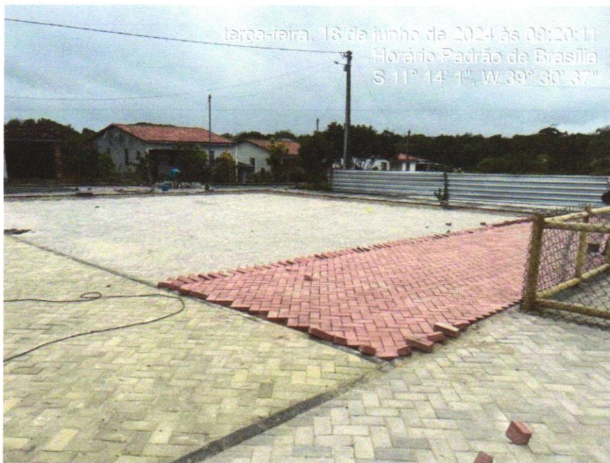
Foto 22 - Pintura p/ piso c/ aplicação de 2 demãos tinta novacor, cores cerâmica, concreto, verde ou azul - aplicação c/ rôlo - R1
