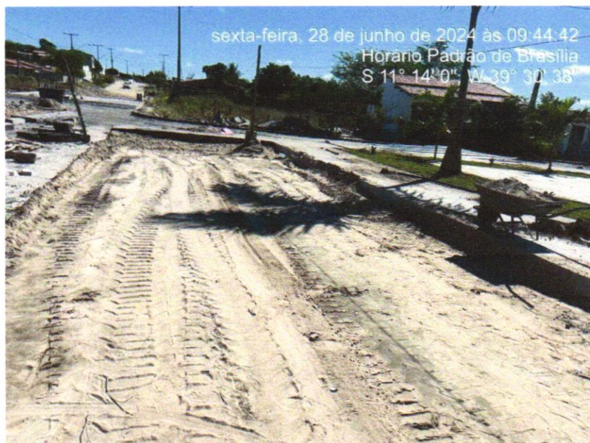
Foto 02 - REGULARIZAÇÃO E COMPACTAÇÃO DE SUBLEITO DE SOLO PREDOMINANTEMENTE ARENOSO. AF_11/2019
